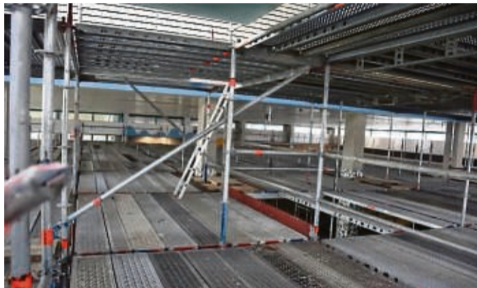
Der Blick vom Drei-Meter-Brett des Sprungturms ist derzeit ein anderer – und zwar auf eine mit Gerüsten gefüllte Schwimmhalle.
