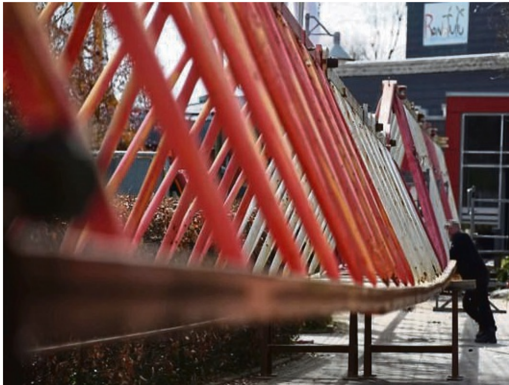
75 Meter lang ist der Kranaufleger, der die Dachdecker beim Neubau des neuen Ronolulu-Dachs unterstützt.
