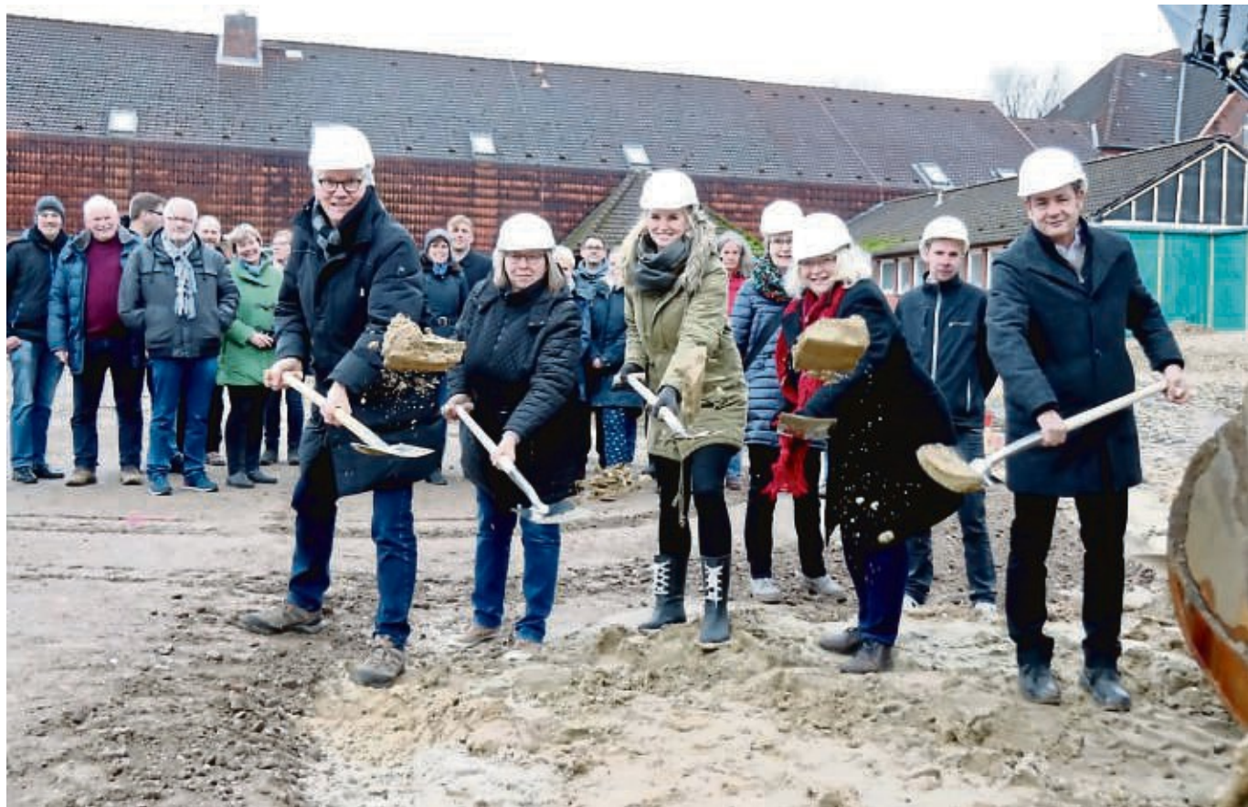
Ralf Goebel (von links), Irmtraut Pape, Jessica Hermonies, Cathrin Puschmann und Martin Menzel machen mit dem ersten Spatenstich symbolisch den Anfang auf der Primar-Campus-Baustelle. Fotos: Nina Baucke
